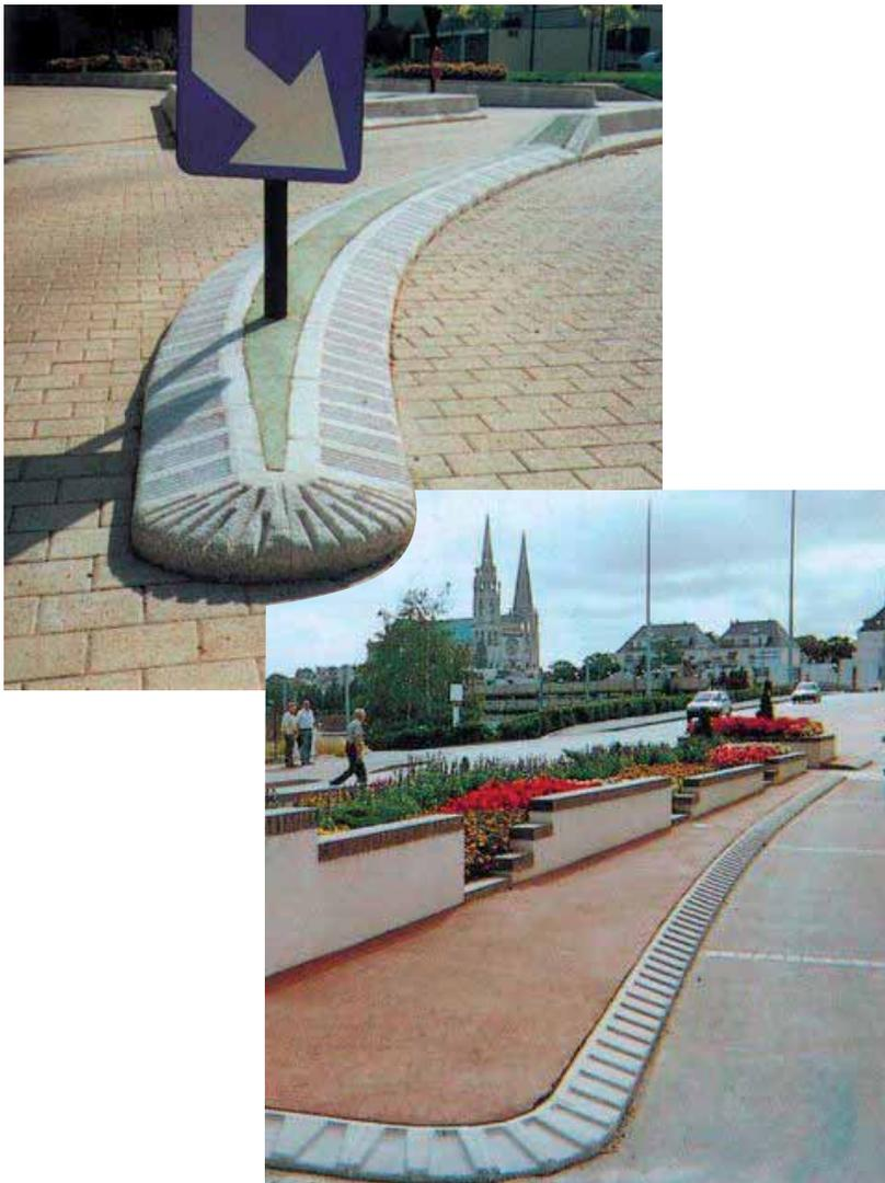
Ils peuvent être réalisés à partir de bordures spécialement prévues pour cet emploi (bordure de type I). Le profil des bordures peut permettre leur emploi comme avertisseur acoustique afin d'alerter les conducteurs les chevauchant. Il peut être complété, le cas échéant, par un avertisseur visuel.
